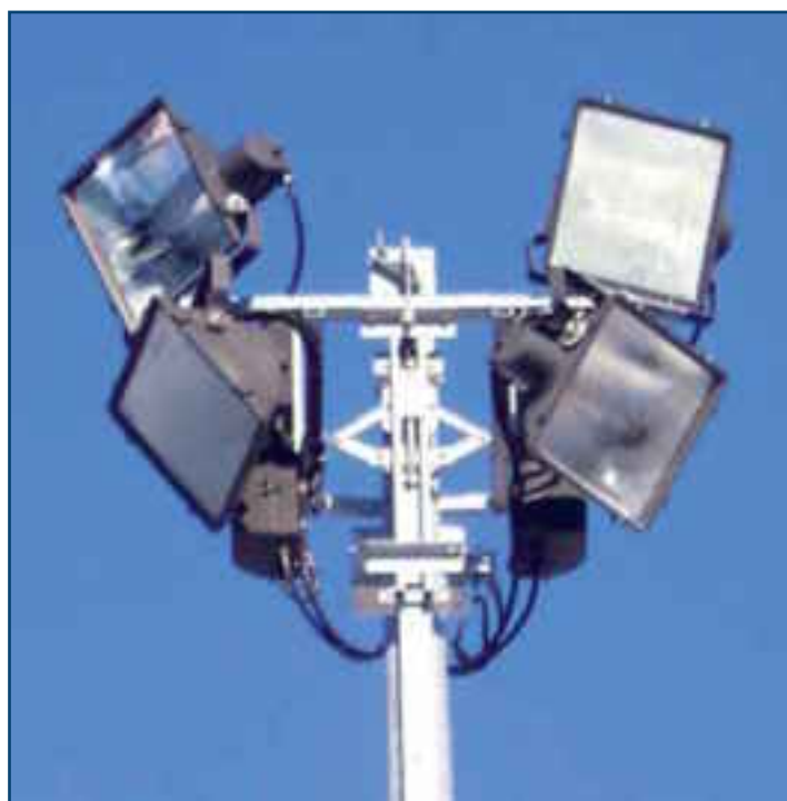
Installazione BIG - Modena
