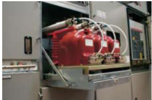
TV in posizione di estratto. VT draw-out position.
