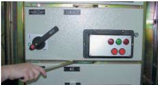
cassetto in posizione di sezionato drawer in disconnected position
