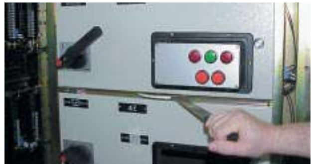
cassetto in posizione estraibile drawer in removable position
