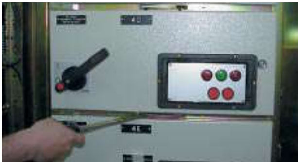
cassetto in posizione di inserito drawer in connected position
